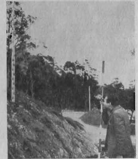
Fig. N° 101-B - Manejo del nivel de mano Abney
