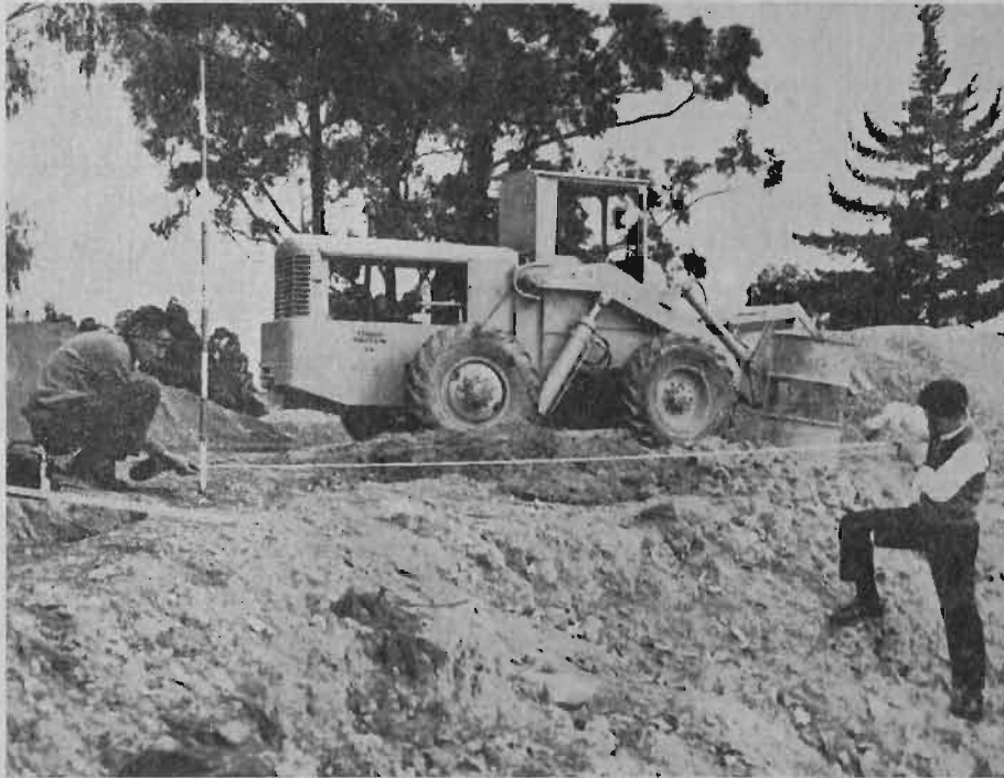
Fig. N° 16 - Medición con cinta en terreno inclinado
